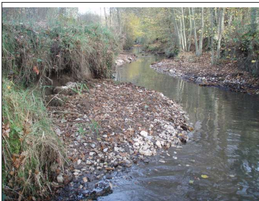
Illustration 10: Mise en place de banquettes (crédit photo SEBB)
