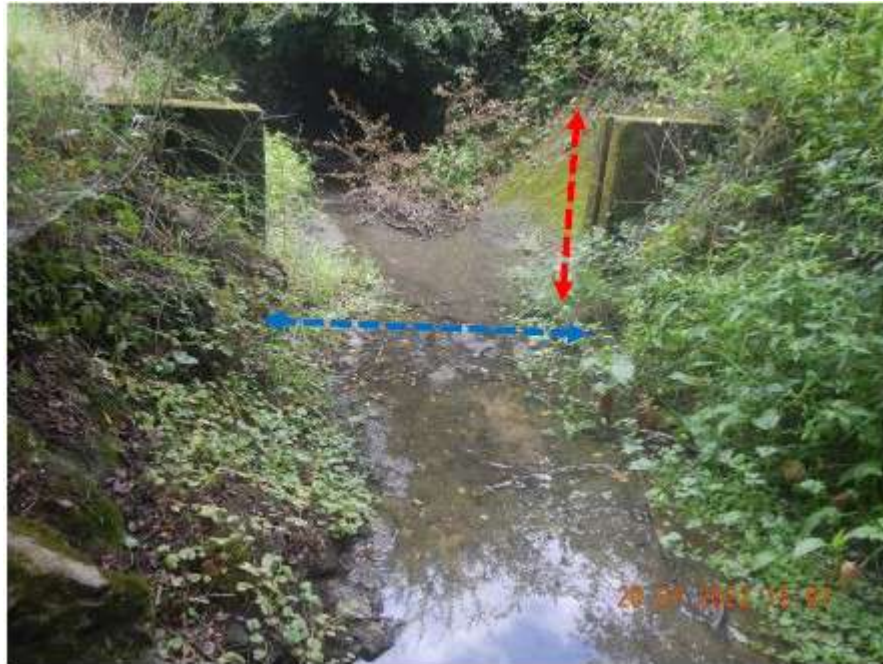
Illustration 4: Ouvrage à araser (crédit photo SEBB)
