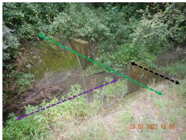
Illustration 3: Ouvrage à araser (crédit photo SEBB)
