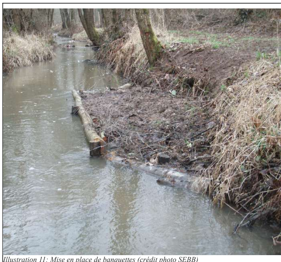
Illustration 10: Mise en place de banquettes (crédit photo SEBB)
