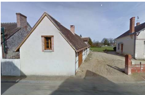
Illustration 2: Vue depuis la maison seigneuriale vers le site de travaux (Source: google street)
